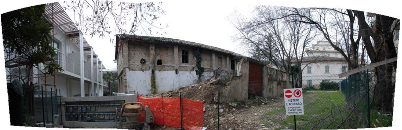
Panoramica Filanda e Casino - La struttura della Filanda parzialmente abbattuta a seguito dei lavori di costruzione del nuovo stabile
