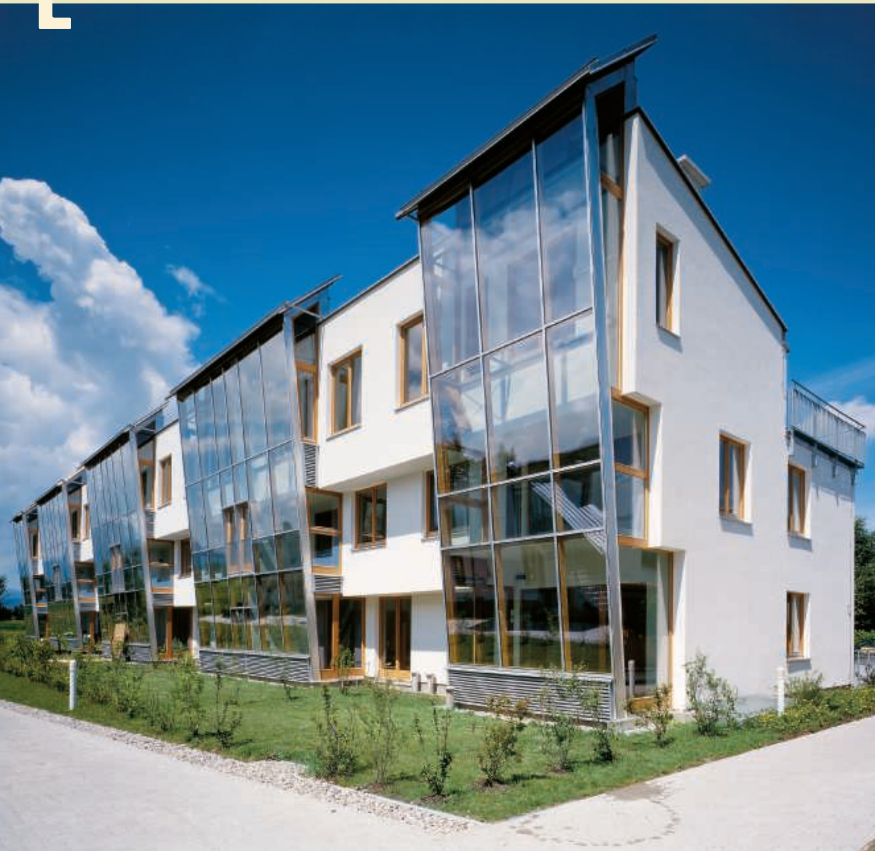
Vista sud dell'edificio III
