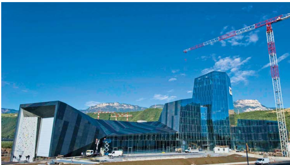
Nelle immagini (foto Claudia Ziegler), la nuova sede del Gruppo Oberalp/Salewa a Bolzano. Il progetto – di Cino Zucchi con Park Associati – è in via di conclusione, è stata recentemente inaugurata la parete di roccia.
