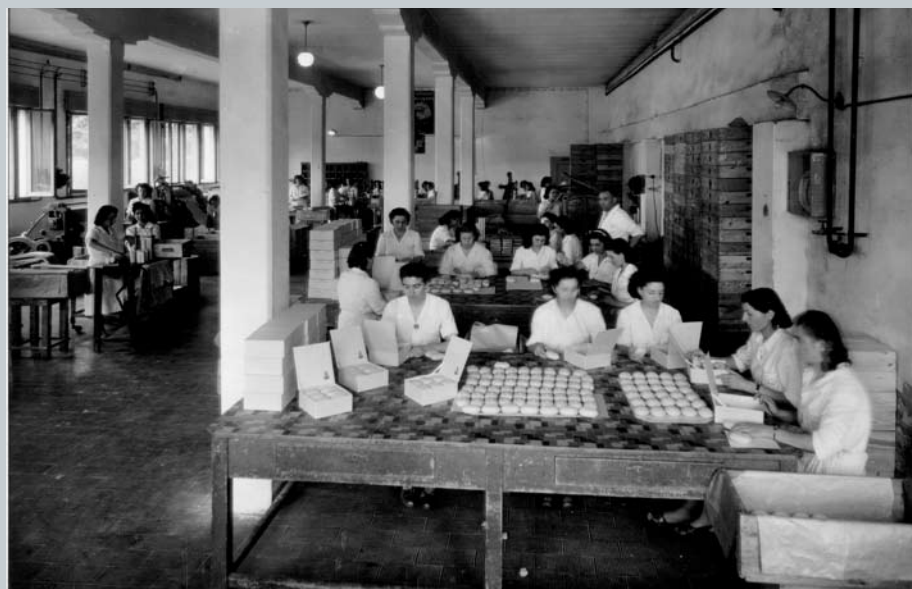
Interno stabilimento Vidal Archivio fotografico dell'Ente della Zona Industriale di Porto Marghera
