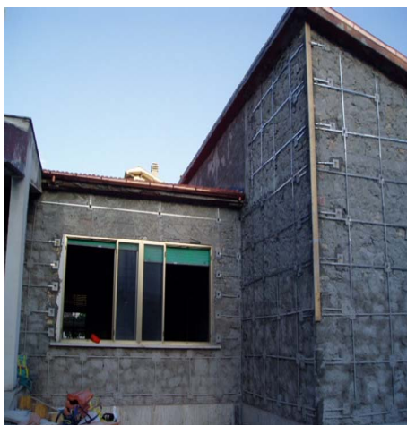
Adeguamento sismico di edificio scolastico in muratura, durante la chiusura estiva, senza lo smontaggio degli infissi e degli impianti.
