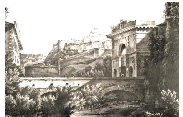
Brescia - Porta Pile con il Garza (1817)
