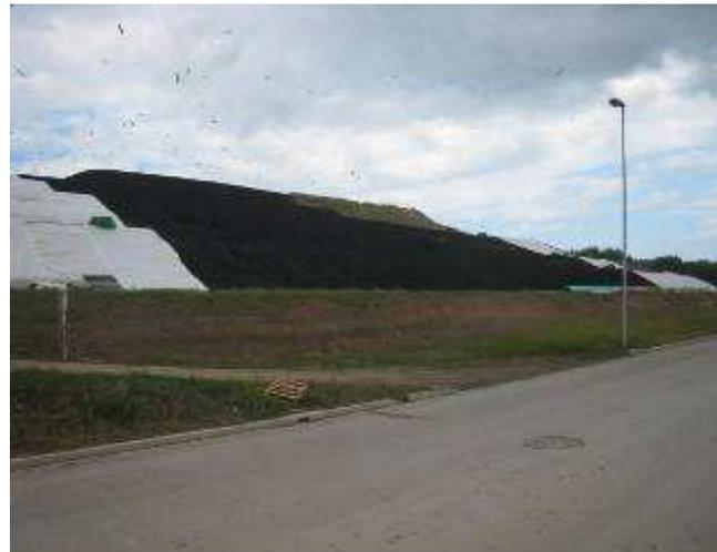
*Esempio di copertura definitiva di una discarica di RSU mediante elementi geosintetici*
