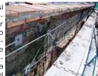
Cordolo tipo GIUFFRE', senza necessità di demolire la muratura e la copertura, realizzato con due correnti parallele e collegamenti diagonali. (Sant'Agata Militello ME)
