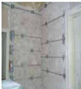
Collegamenti attivi tra setti murari (Vittoria)
