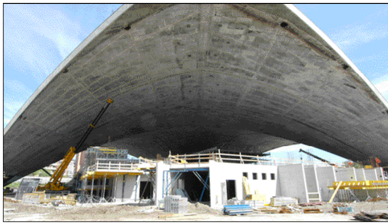
Un'immagine di cantiere del Palavela di Torino, trasformato secondo il progetto di Gae Aulenti in occasione dei XX Giochi Olimpici Invernali del 2006. L'impianto per il pattinaggio artistico e lo short-track (2° lotto) è stato realizzato con la formula dell'appalto integrato
