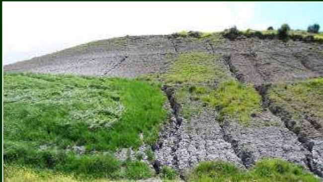
ANAS SPA: VAL D'AGRI (PZ), SS 92 – VARI LOTTI LA ZONA DI SX E' TRATTATA CON I PRATI ARMATI® QUELLA DI DX NON TRATTATA E CALANCATA
